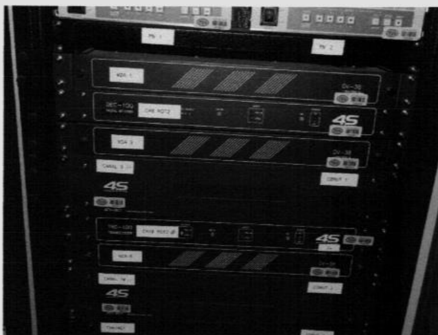
Vista dos transcoder, decoder e comutadores de video/áudio “4S-AFV801/TRC100/DEC100”
